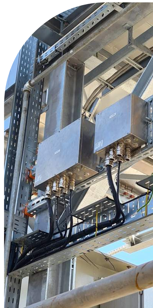
Fijación mural con orejas de fijación que están en la base de la caja
