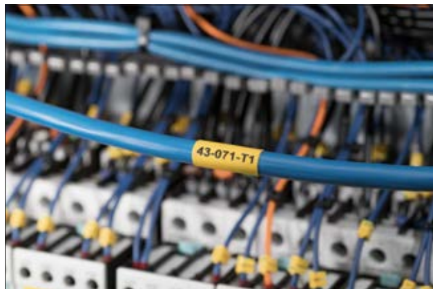
TLFX - marcador termocontrátil livre de halogêneo.
