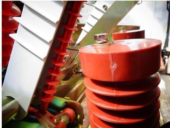
4.- Con los aisladores ya fijados en el seccionador, se debe proceder a conectar los cables a los puntos de tensión capacitiva del aislador. Los cables vienen con una longitud aproximada de 2m, medir la distancia necesaria y cortar el excedente.
